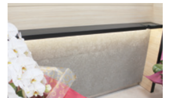
窓口カウンターのリサイクル内装ボード
