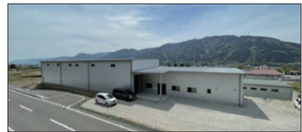
経営者の故郷における新工場建設
