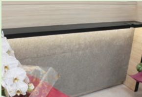
窓口カウンターに古紙や現場廃材を再利用した「リサイクル内装ボード」を採用
