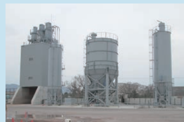
焼却灰リサイクル施設
