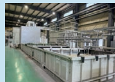
補助金活用により導入した新設備
