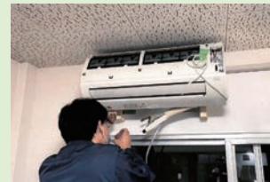
空調機器のメンテナンスにより、 CO 2 排出量削減に寄与
